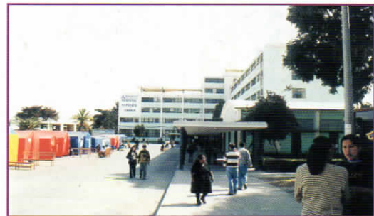
Foto 19. Desalojo en el Hospital Hipólito Unanue de Tacna por daños no-estructurales.
