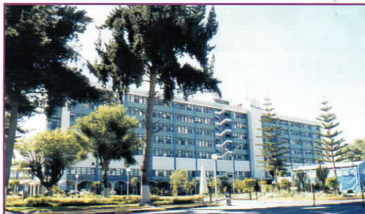
Foto 16. Hospital Nacional Carlos Alberto Segúin de Arequipa sin daño estructural pero desalojado por daños en la tabiquería.
