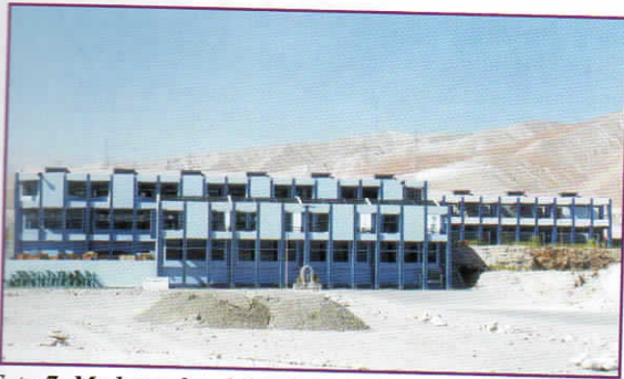
Foto 7. Moderno local del Colegio Santa Fortunata, en El Cerrillo, Moquegua.
