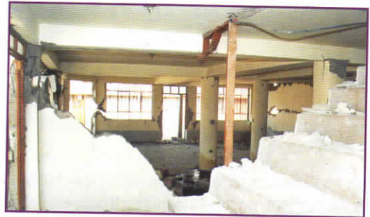
Fotos 24 y 25. Viviendas colapsadas de tres pisos en albañilería y concreto armado, Tacna.
