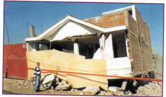
Fotos 24 y 25. Viviendas colapsadas de tres pisos en albañilería y concreto armado, Tacna.
