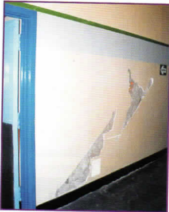
Foto 21. Los tabiques del Hospital Carlos Alberto Seguín controlaron los desplazamientos laterales y disiparon energía durante el sismo.
