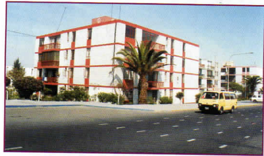
Foto 38. Edificio de departamentos muy rígido y antiguo sin daños en Tacna.
