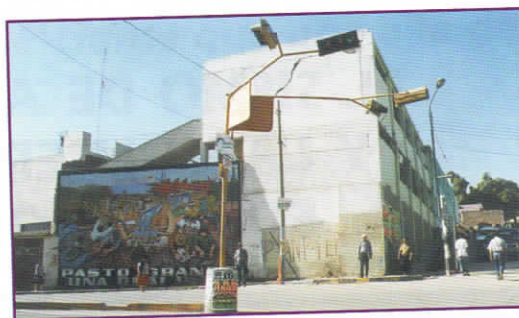
Foto 4. Daño irreparable en el Centro Educativo Angela Barrios de Moquegua.
