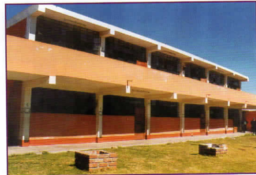
Foto 41. Pabellón tradicional aporticado sin daños gracias al muro de cierre completo en la cara paralela a la fachada principal.
