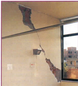
Foto 16. Hospital Nacional Carlos Alberto Segúin de Arequipa sin daño estructural pero desalojado por daños en la tabiquería.
