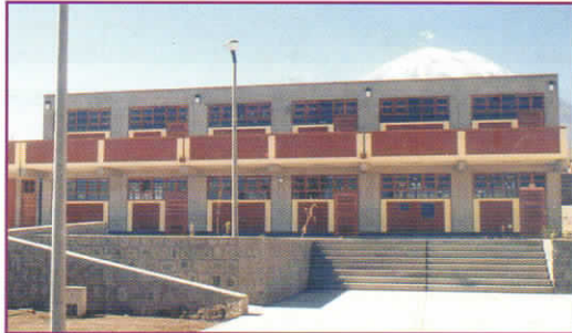
Foto 15. Centro educativo construido de acuerdo a la Norma Peruana de Diseño Sismorresistente de 1997 sin daño alguno, Arequipa.
