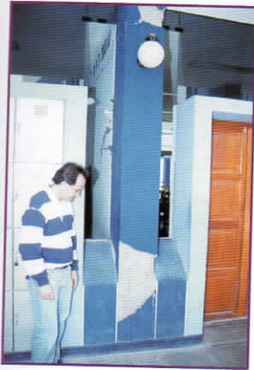
Foto 8. Vigas y columnas separadas de los elementos no-estructurales, Colegio Santa Fortunata en El Cerrillo, Moquegua.
