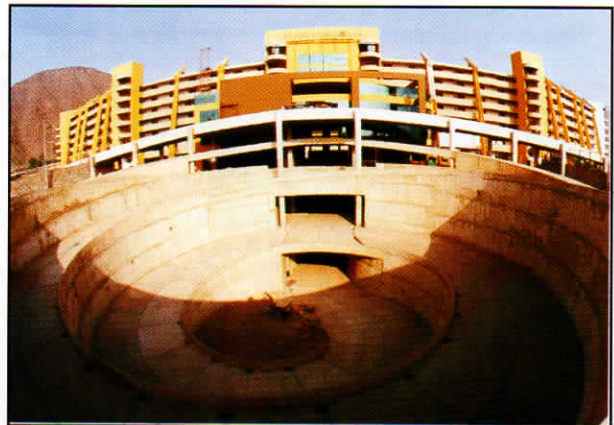
Figura 14. Vista panorámica donde se aprecia la estructura de exteriores de la edificación y los cinco niveles mencionados en el texto.
