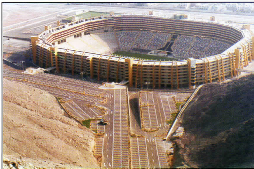
Figura 1. Vista panorámica del cuerpo principal del Estadio Monumental. 22 edificios independientes entre sí circundan toda la cancha y las graderías adyacentes.
