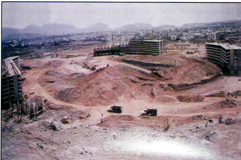
Figura 3. Inicio de la construcción en varios frentes. Dos bloques en Occidente, otros dos en Oriente y tres en Sur-Occidente, además del inicio de la excavación de la cancha principal y graderías.
