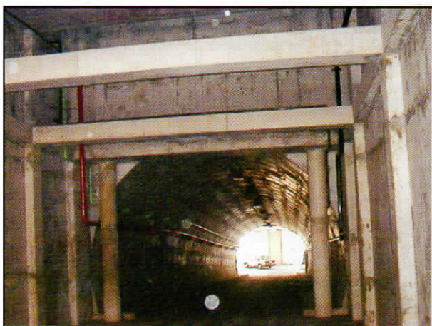
Figuras 15 y 16. Corte transversal del túnel en etapa de construcción y su acabado final.
