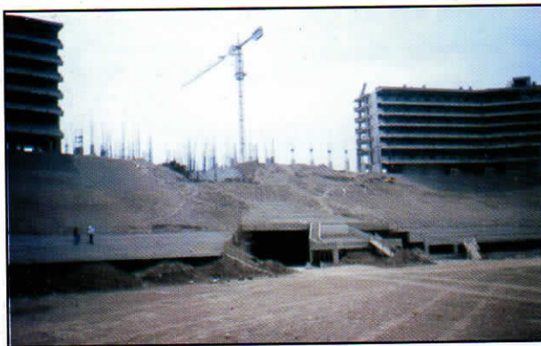
Figura 20. Vista panorámica de la zona de Vestuarios. Nótese en la parte central la Nave Principal en donde el empuje del terreno será resistido por una serie de pórticos que confluyen en una única placa rígida ubicada justo entre las dos salidas a la cancha.
