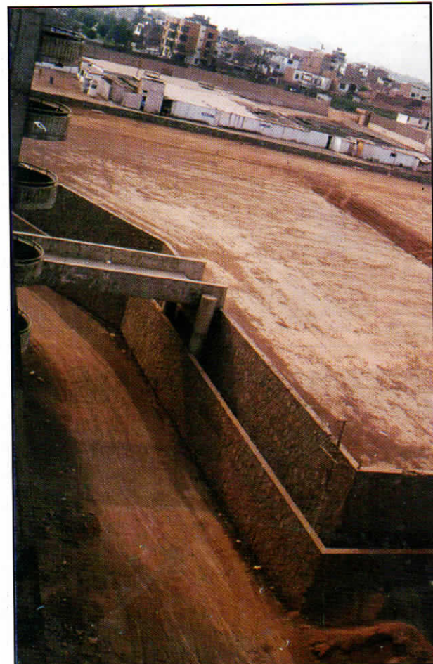
Figura 21. Puente de acceso a palcos desde estacionamientos independizados del acceso del público a graderías mediante muros de gravedad construidos con mampostería de piedra.
